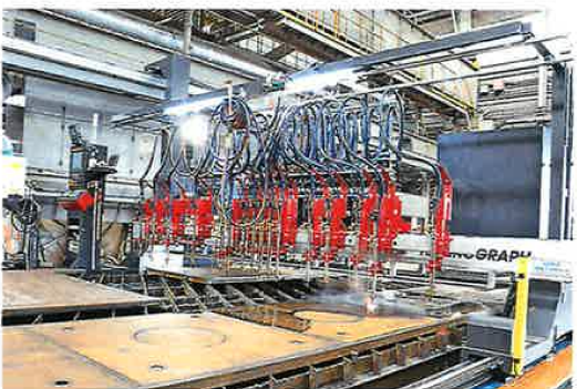
自動火災制御装置を活用し「技能伝承」を円滑に（ダイヤフラム部材を切断）
